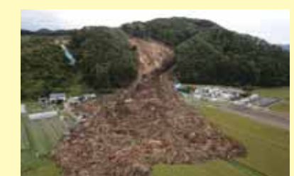
厚真町斜面崩壊(2018.9.)
