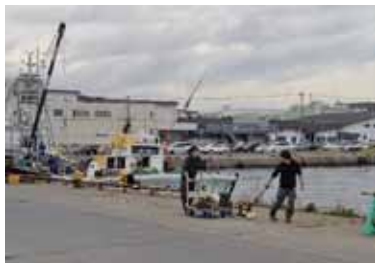
漁港の陥没危険箇所抽出
